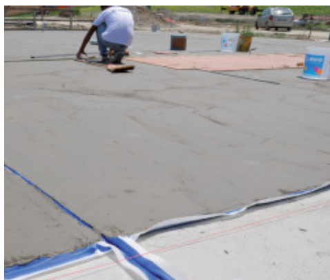
Hidroizolarea sapelor cu Mapelastic si Mapeband
