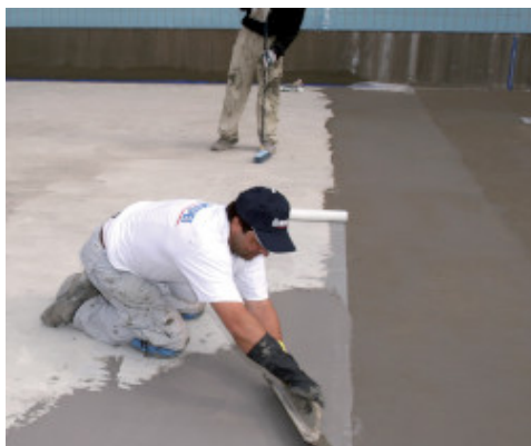
Hidroizolarea unei piscine cu Mapelastich
