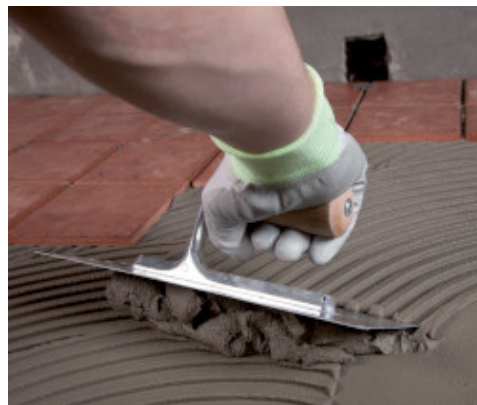
Aplicare Granirapid pe o terasa hidroizolata cu Mapelastich
