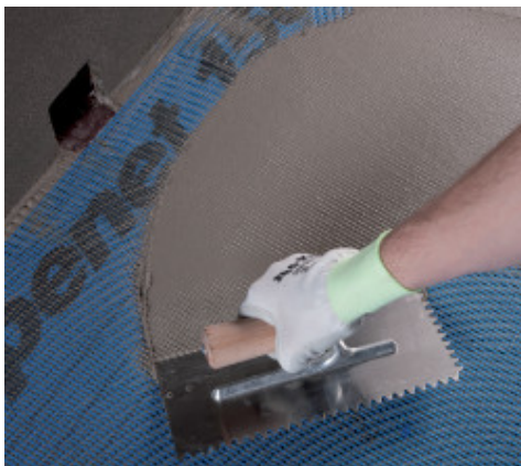
Aplicare Mapelastich pe Mapenet 150
