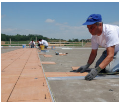
Montarea placilor ceramice cu Kerabond + Isolastic
