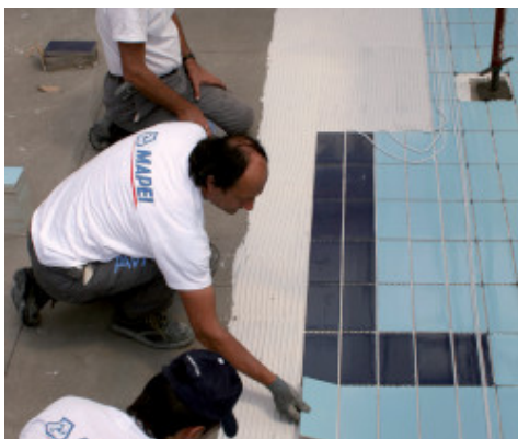
Montarea placilor ceramice pe Mapelastich într-o piscină
