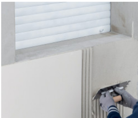
Montarea placilor ceramice de format mare
